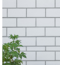
Metselwerk met calciumsilicaat
